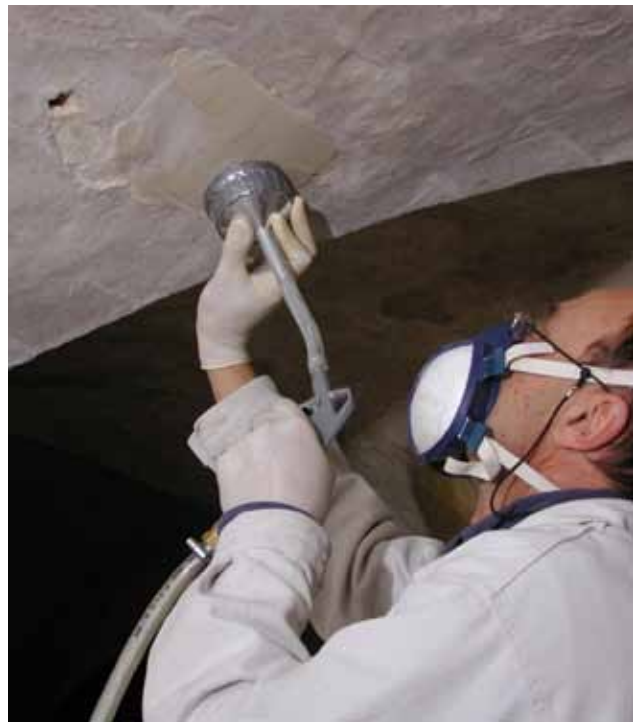
[23] Anwendung des Niederdruckverfahrens
