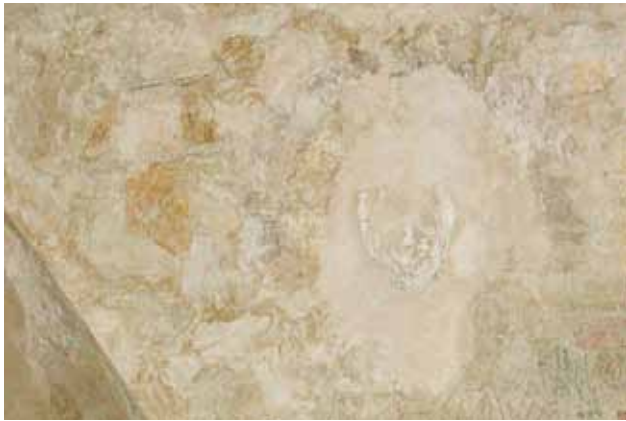
[29] Gewölbefeld III, Vorzustand
