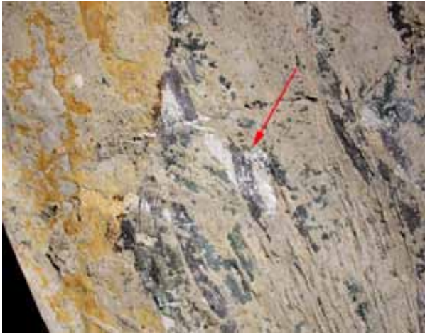
Abb. 1 Die ursprüngliche Putzfarbigkeit, durch vormals aufliegende Tünchereste bewahrt, verdeutlicht die Intensität der Farbvertiefung und Vergilbung des Polymerfilms, Quedlinburger Gewölbmalereien, Bildbreite ca. 6,5 cm.
