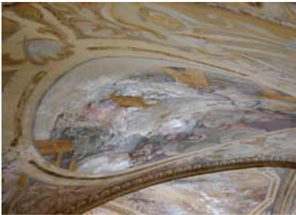
Abb. 2 Differenziertes Glanzbild durch Eintrag einer Acrylharz-Dispersion auf unterschiedlich stark saugenden Untergrund, Malereien in der Barbarakapelle der Burg Grabštejn in Tschechien.
