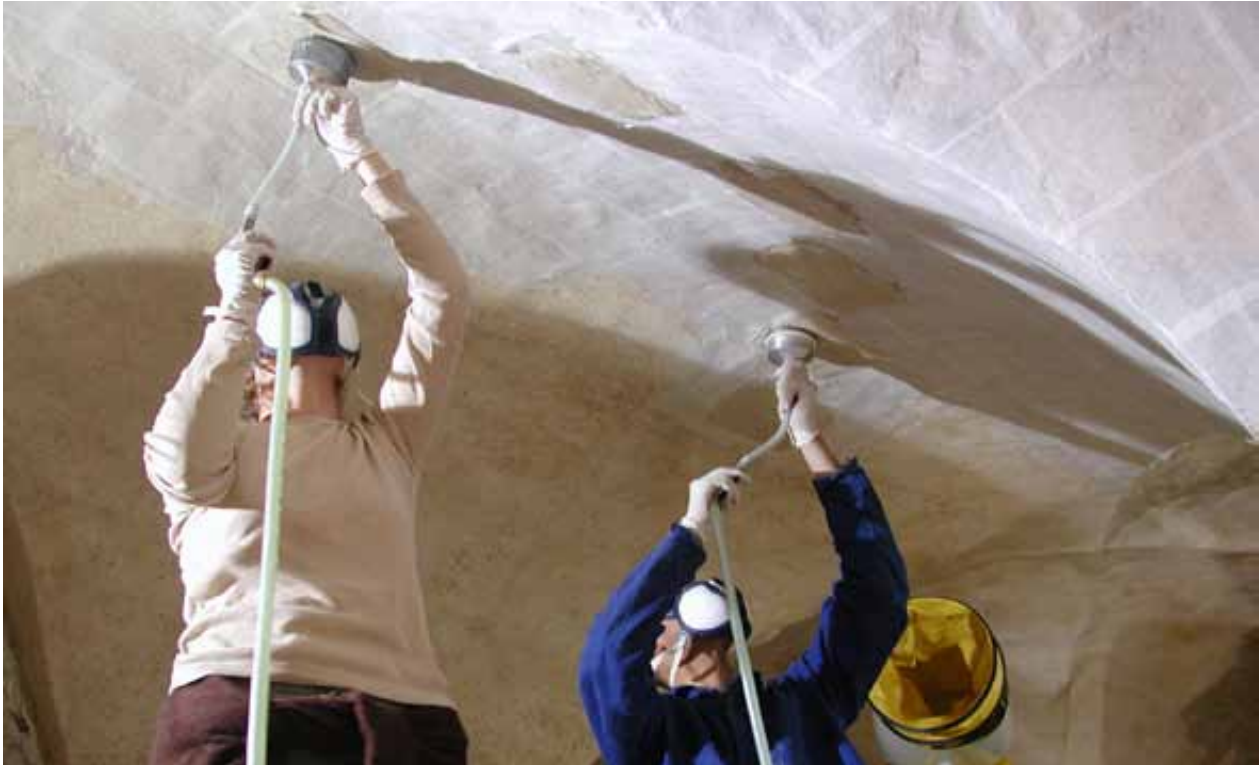
Abb. 9 Anwendung der Niederdruckvorrichtung, Quedlinburg 2004.
