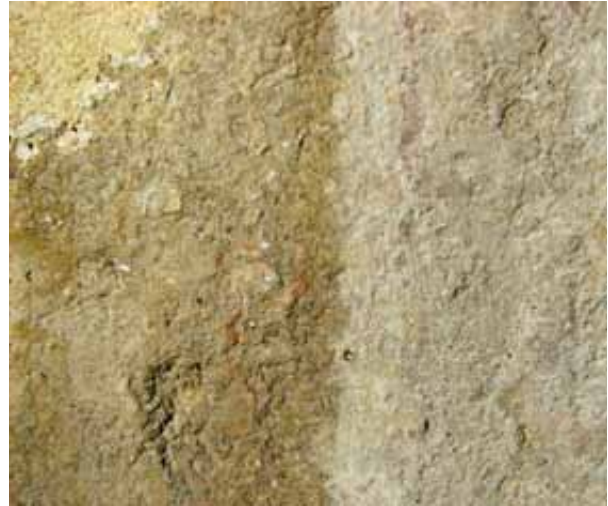
Abb. 14 Detail, Aufhellung der Oberfläche nach der Anwendung des Niederdruckverfahrens, Bildbreite ca. 8 cm.
