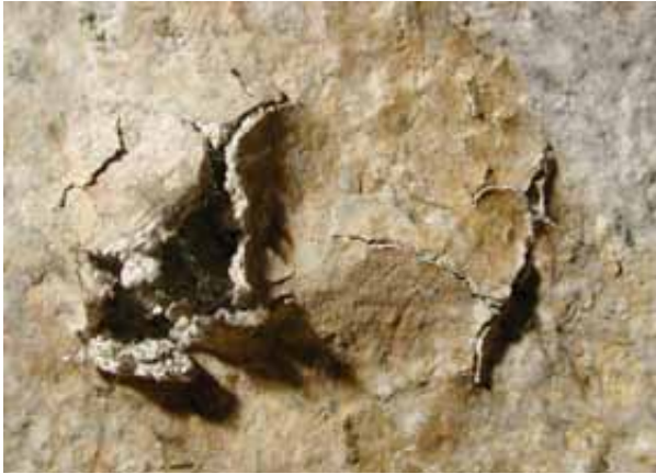
Abb. 4 Blase mit deformierter Putzhaut, Gewölbemalereien in der Krypta der Stiftskirche St. Servatius in Quedlinburg.
