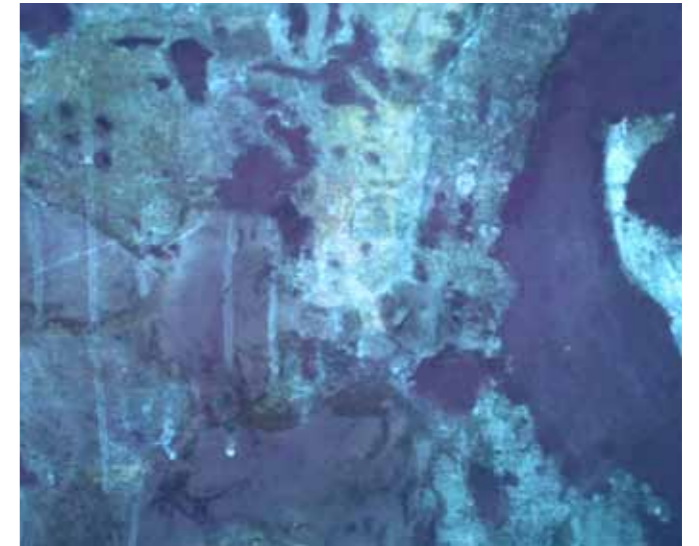
Abb. 8: Gewölbmalereien Stiftskirche Quedlinburg, Feld III, UV-Aufnahme, Zustand vor der Bearbeitung 2004
