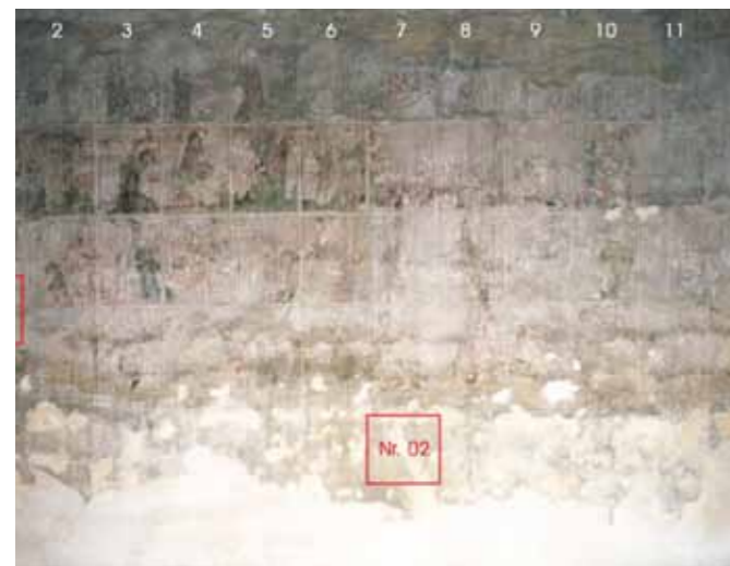
Abb. 15: Lokalisierung der Testflächen, Außenwandmalereien der Kirche St. Nikolai in Jena-Lichtenhain
